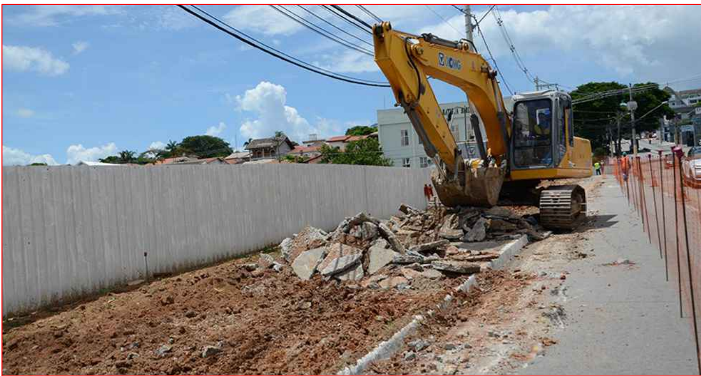
Remoção de Pavimento Intertravado "Paver"
